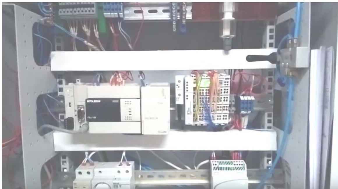
Рис. 2. Система управления автоматической расфасовки сыпучих материалов в ГК
